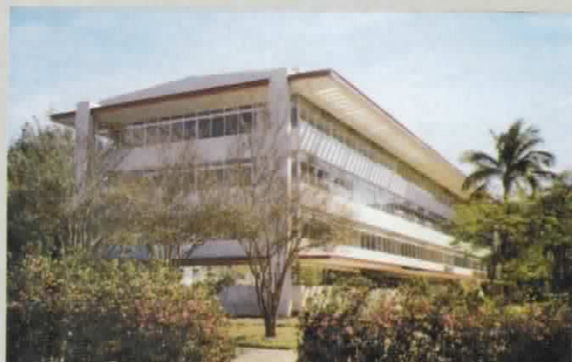
Em obras: prédio do Areão é preparado para abrigar os setores administrativos da instituição
