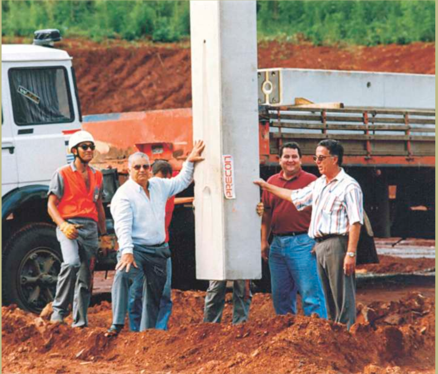
1996 - Início das obras de Construção do Campus da Funcesi
